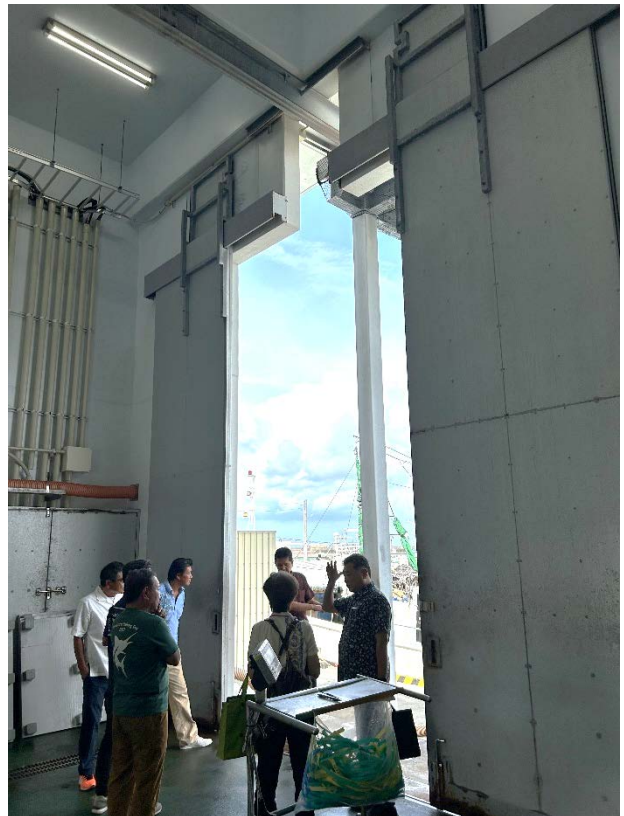
シャッター一部
