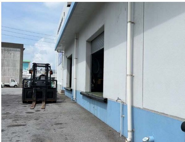
荷さばき施設出荷用扉
