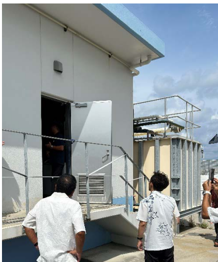
ポンプ室及び海水処理施設
