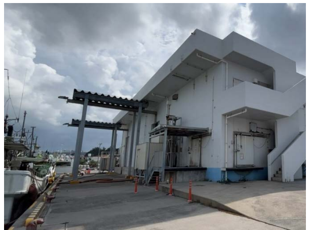
荷さばき施設水揚げ側
